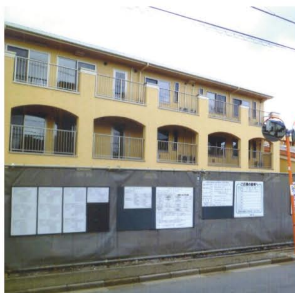
建設中の特別養護老人ホーム(みやぎ台)
