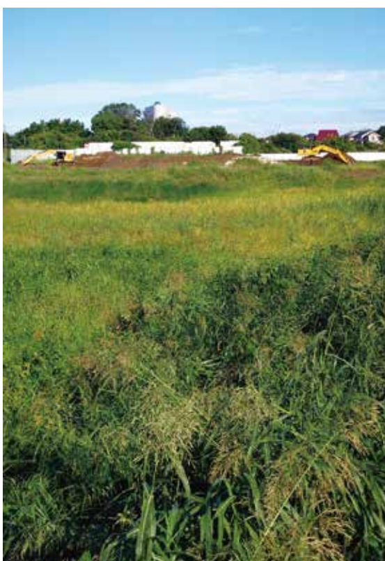
海老川調節池の整備現場 東町
